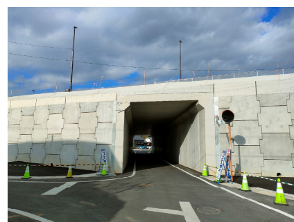
事例：国道3号植木バイパス (内空幅5m×内空高6.75m)
